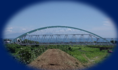
水無川の橋梁群
